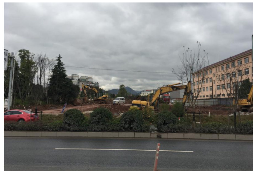
图 5.3-15 寿昌航空小镇综合停车场选址现状图
