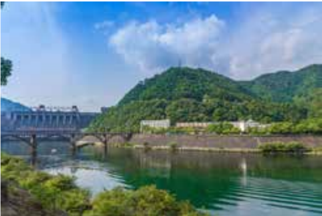
新安江水电站
