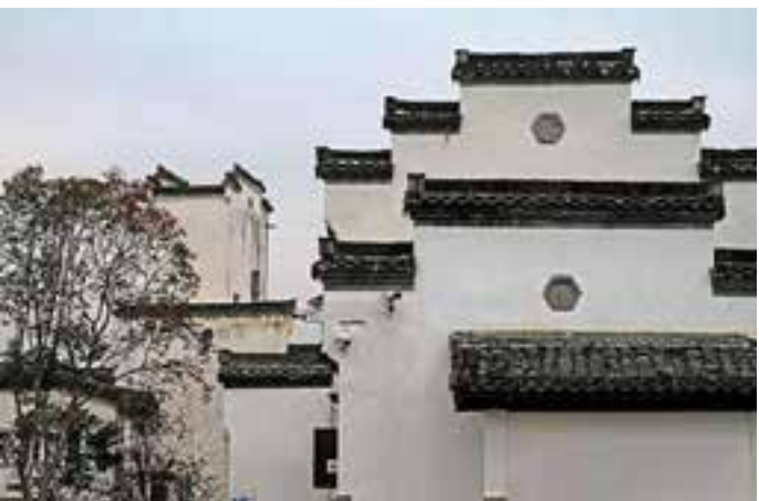
建德传统建筑
